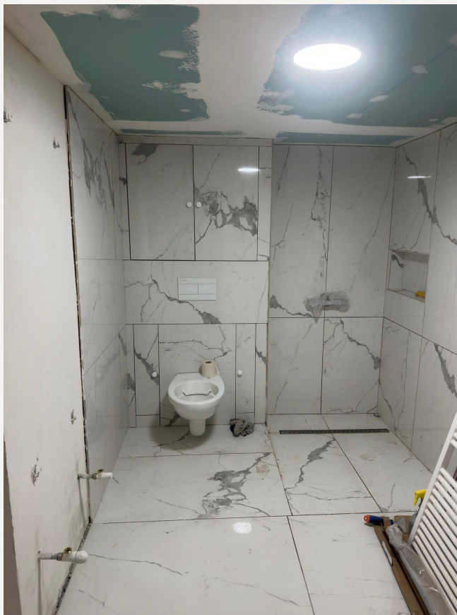
EN COURS - carrelage et plafond
