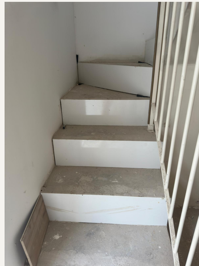
EN COURS - escalier
