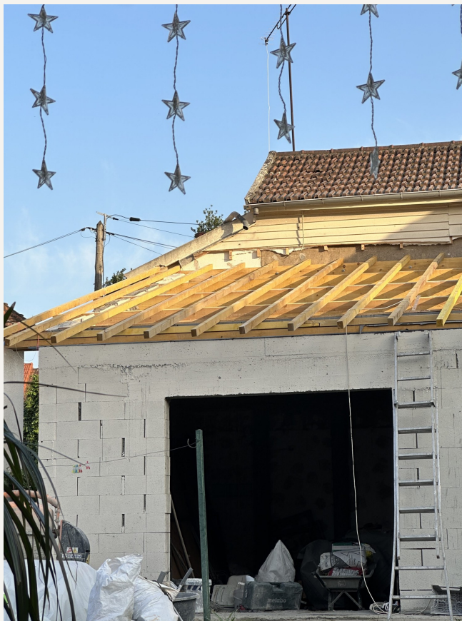
EN COURS - toiture et maçonnerie
