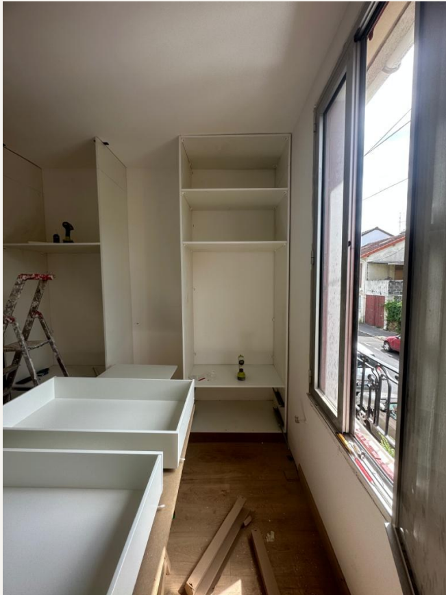
EN COURS - assemblage
